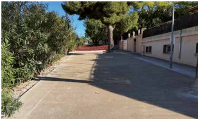
Al passeig de Can Sagrera s'ha fet l'adequació i estabilització dels parterres
